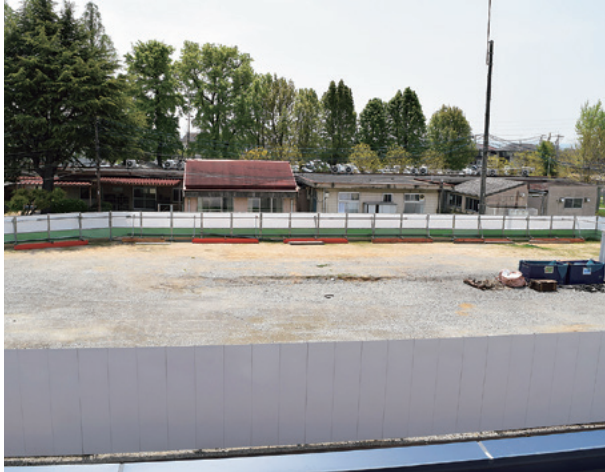
Ⅱ、Ⅲ期工事予定地。柵で囲った手前のスペースのほか、奥に見える建物を取り壊して3棟を建設する
