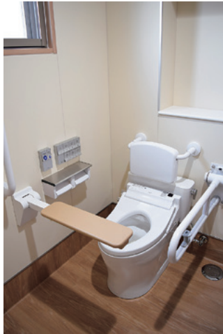
背もたれや可動式の手すりが付いたトイレ
